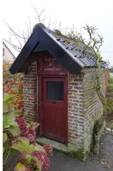
Détail de la façade principale. Phot. Delphine Volto Jourdan IVR32_20245902629NUCA
