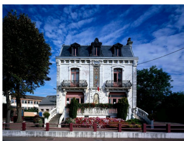
Vue d'ensemble. Phot. Irwin Leullier IVR22_20008000653VA
