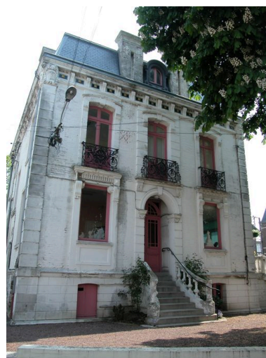
Élévation latérale gauche. Phot. Elisabeth Justome IVR22_20048001561NUCA
