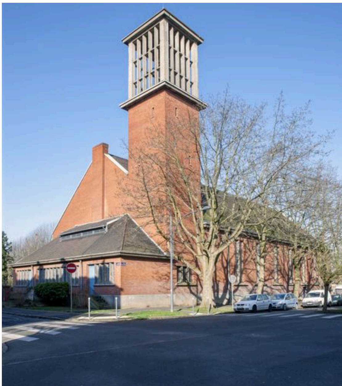
Élévation postérieure et flanc gauche.
