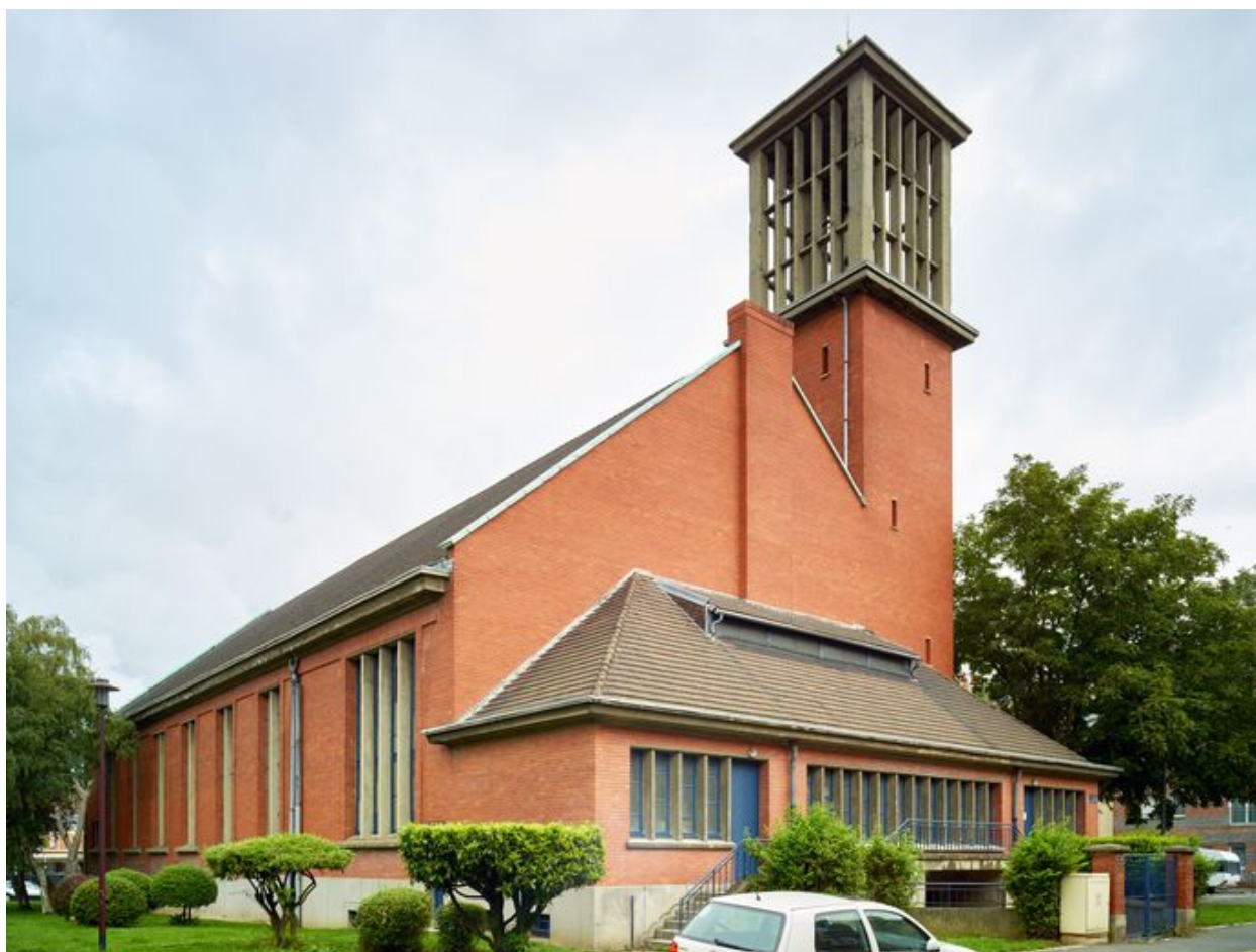
Élévation postérieure de l'église.
