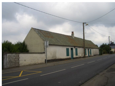
Vue générale. Phot. Inès Guérin IVR22_20078005176NUCA
