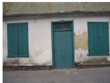
Détail des trois travées de la seconde partie habitable. Phot. Inès Guérin IVR22_20078005178NUCA
