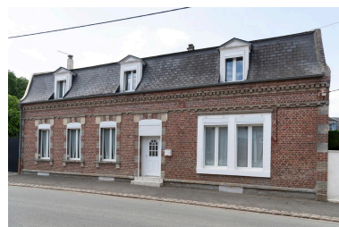
Ancien café de la Gare, n°14 rue de la Gare, vue depuis le sud-est. Phot. Marc Kérignard IVR32_20226000708NUCA
