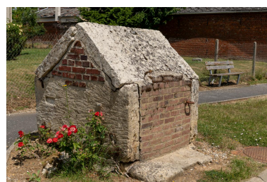
Puits de la Neuve Rue, en face de la mare, vue depuis le sud. Phot. Marc Kérignard IVR32_20226000683NUCA
