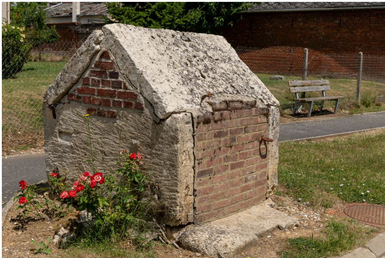
Puits de la Neuve Rue, en face de la mare, vue depuis le sud.
