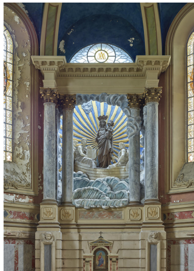
Vue générale après restauration en 2023. Phot. Pierre Thibaut IVR32_20236200259NUCA
