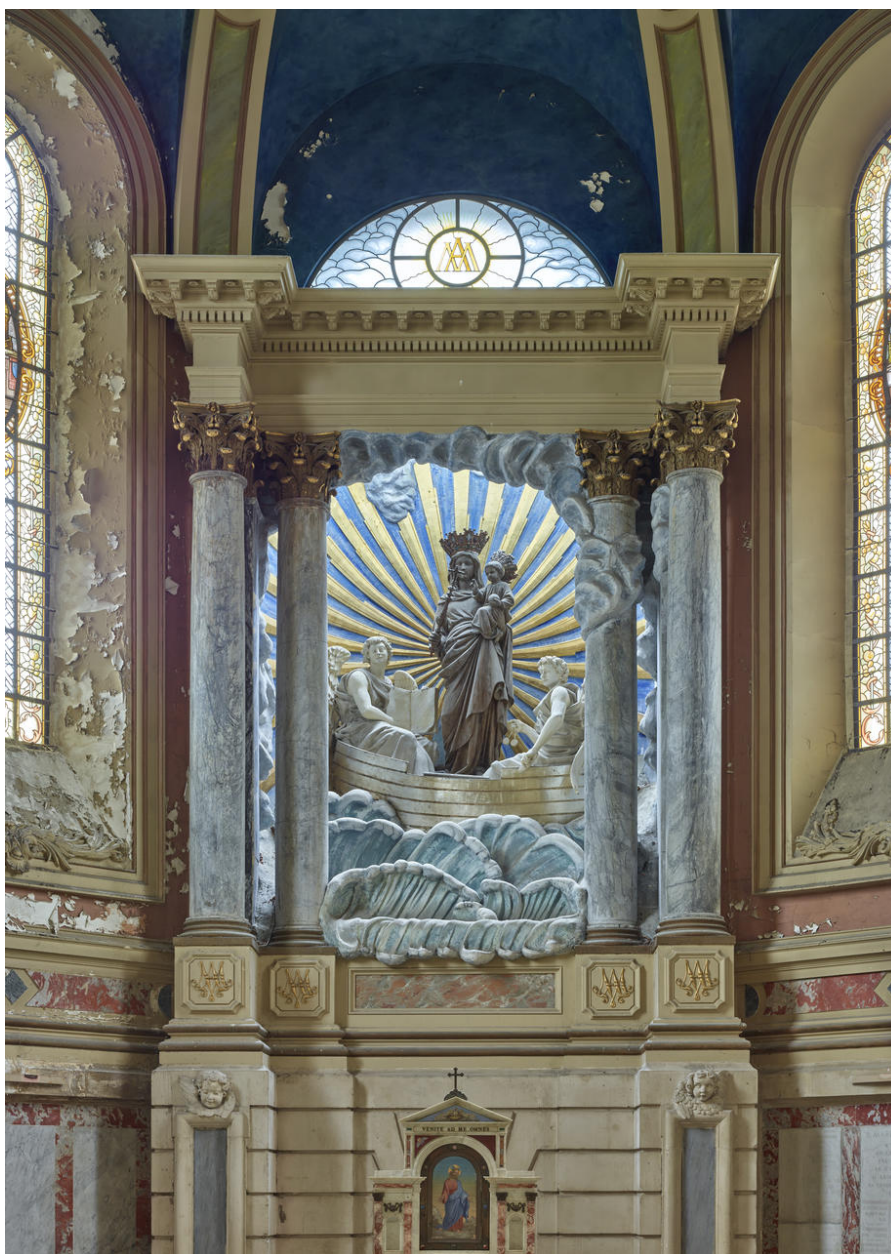
Vue générale après restauration en 2023.
