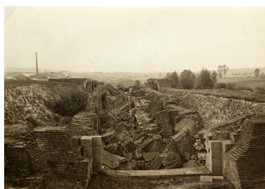
Canal du Nord. Guerre de 1914-1918. Moilains (Somme), écluse 9 détruite, vue prise de l'amont (Musée de la batellerie et des voies navigables, Conflans-Sainte-Honorine). Repro. Bouvet Hubert, Phot. auteur inconnu IVR32_20188000257NUC4A
