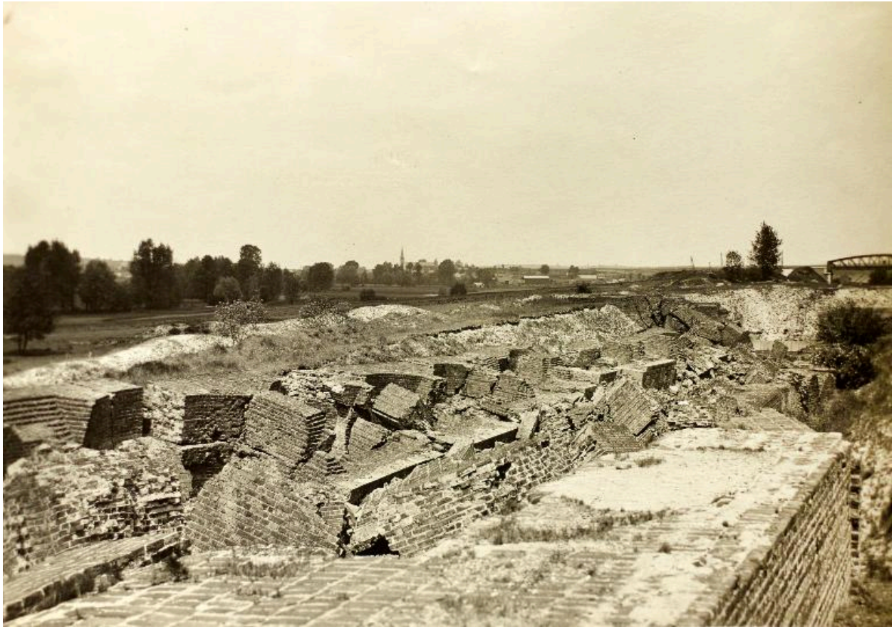
Canal du Nord. Guerre de 1914-1918. Moislains (Somme), écluse 9 détruite, vue prise de l'aval (Musée de la batellerie et des voies navigables, Conflans-Sainte-Honorine).
