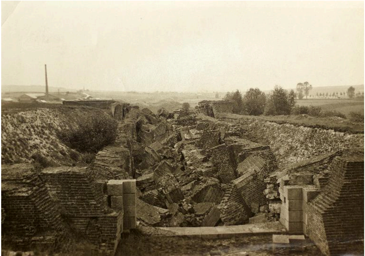
Canal du Nord. Guerre de 1914-1918. Moislains (Somme), écluse 9 détruite, vue prise de l'amont (Musée de la batellerie et des voies navigables, Conflans-Sainte-Honorine).
