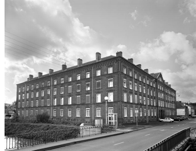
Vue des façades sur rue. Phot. Thierry Lefébure IVR22_20020200819V
