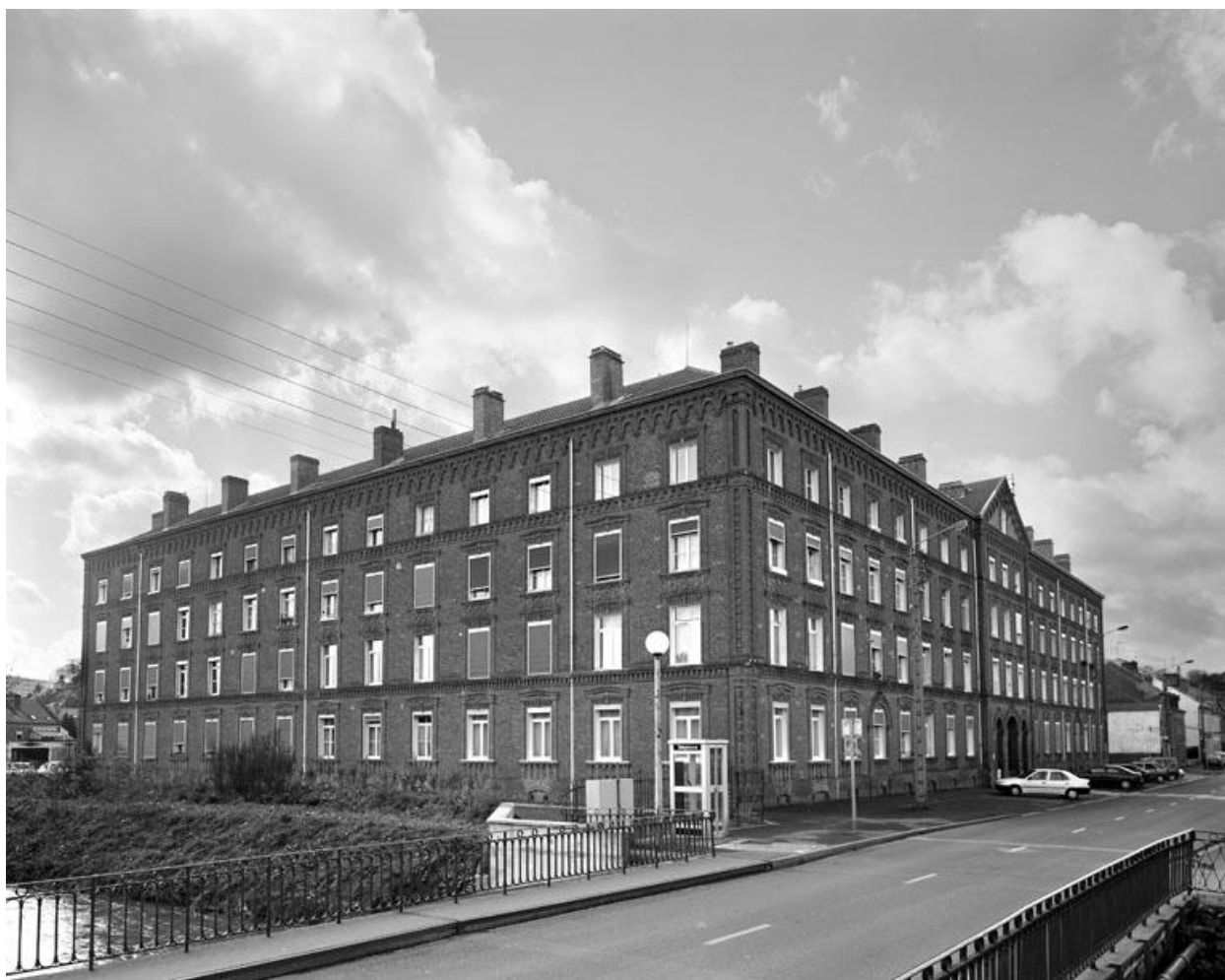
Vue des façades sur rue.
