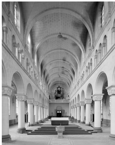
Vue générale de la nef, vers la tribune d'orgue. Phot. Philippe Dapvril IVR31_20025900800V
