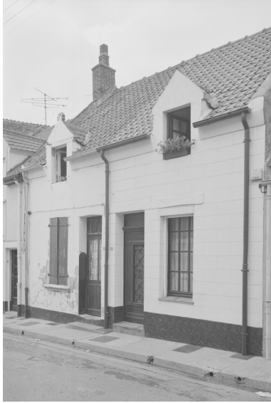
Vue générale des maisons jumelles depuis la rue. IVR31_19836200254X
