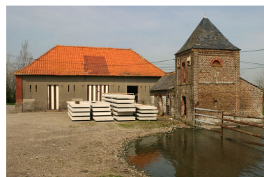
Etables et pigeonnier occupant le côté oriental de la cour. Phot. Irwin Leullier IVR22_20078000193NUC2A
