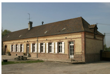
Vue postérieure du logis daté de 1892. Phot. Irwin Leullier IVR22_20078000192NUC2A
