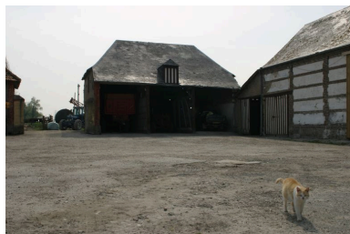
Vue de la charretterie située dans l'angle sud-ouest de la cour, aujourd'hui disparue. Phot. Inès Guérin IVR22_20078006230NUCA
