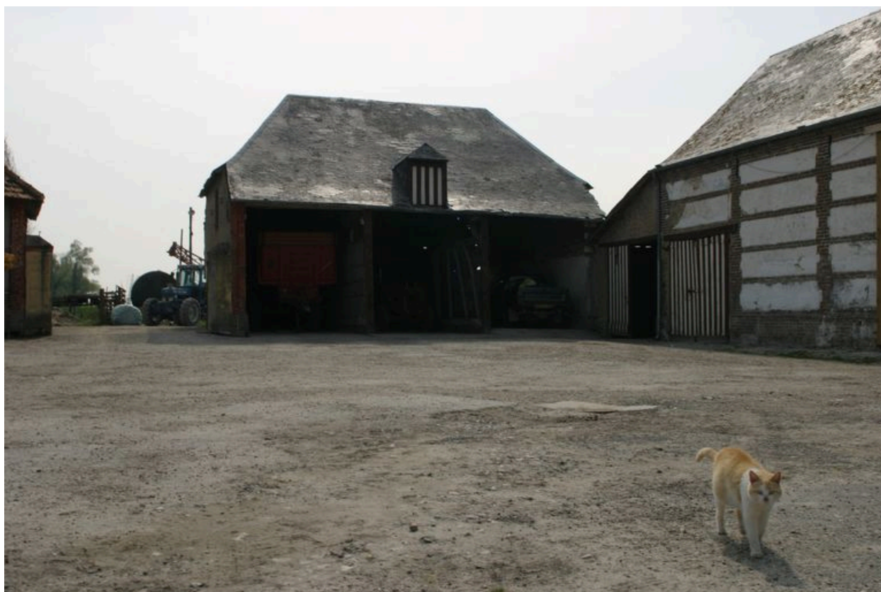
Vue de la charretterie située dans l'angle sud-ouest de la cour, aujourd'hui disparue.
