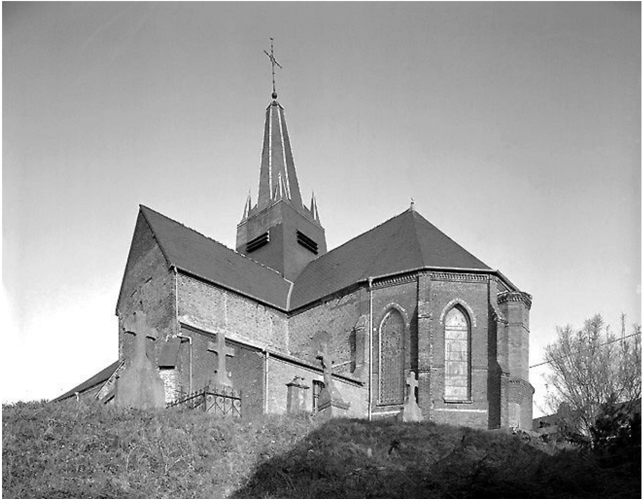
Vue depuis le sud-est.
