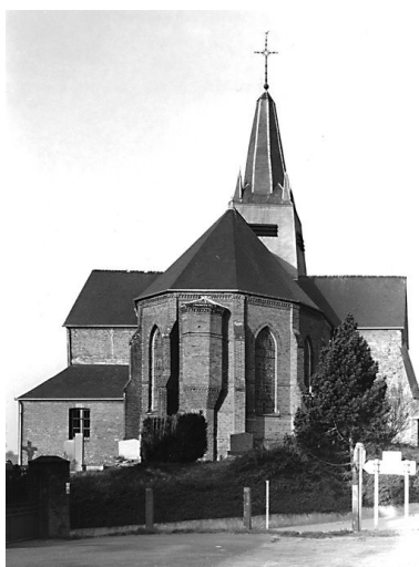
Vue du chevet depuis l'est. Phot. Franck Bürjes IVR22_19990201237X
