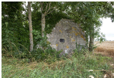
Pignons nord-ouest, vers le sud Phot. Jean-Marc Ramette IVR31_20145905281NUCA
