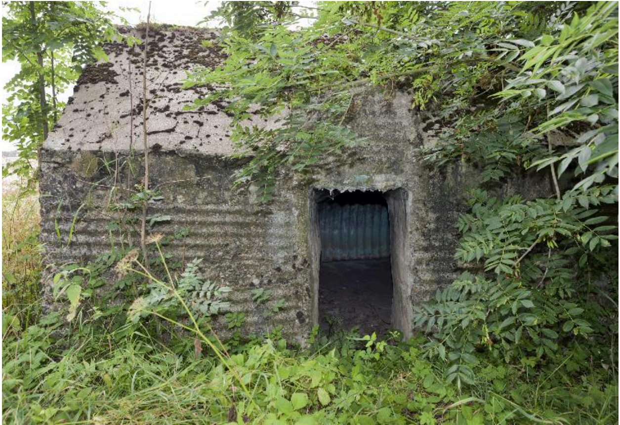
Entrée sur l'élévation nord-est, rue des Sûres
