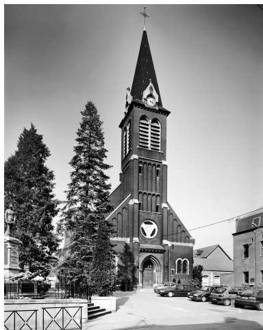
Élévation antérieure. Phot. Thierry Petitberghien IVR31_20025901009V
