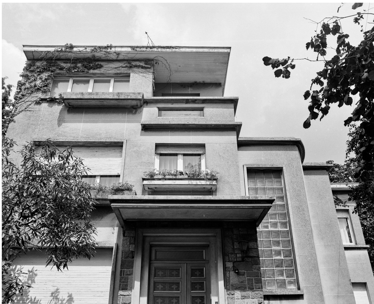
Vue en contre-plongée accentuant les décrochements.
