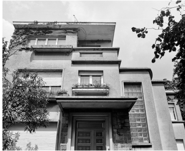
Vue en contre-plongée accentuant les décrochements. Phot. Thierry Petitberghien IVR31_20025901896X
