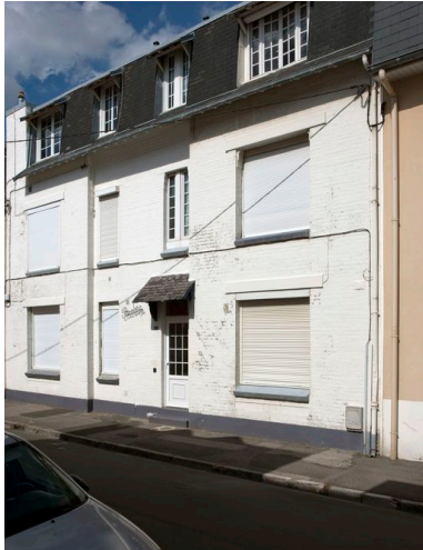
Vue générale. Phot. Pierre Thibaut IVR31_20146202215NUCA
