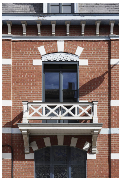
Détail d'une travée avec balcon en bois sur la rue des Arts. Phot. Delphine Volto Jourdan IVR32_20265900040NUCA
