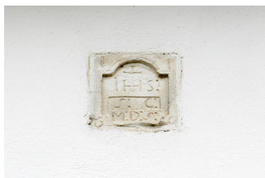
Détail de la date portée sur la façade principale : IHS [S: C:] M: D: S: . Phot. Delphine Volto-Jourdan IVR32_20245902569NUCA
