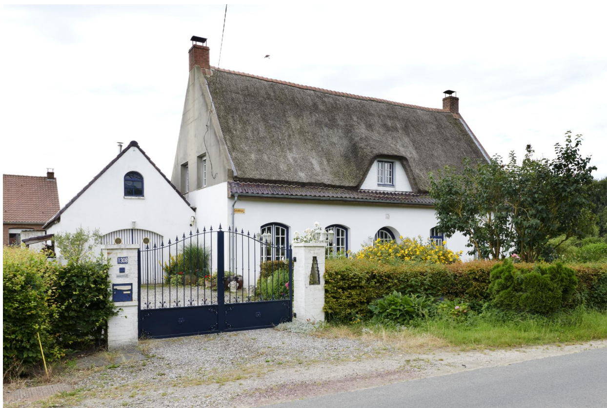
Façade principale et garage.
