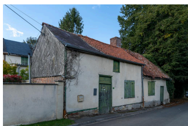
Ancien atelier de serger sur rue (?) avec logis en fond de cour, n°5 rue Fiscale, vue depuis le sud-est. Phot. Marc Kérignard IVR32_20216001019NUCA
