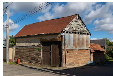
Grange sur rue, n°15 rue de Breteuil, vue depuis le sud-ouest. Phot. Marc Kérignard IVR32_20216001014NUCA
