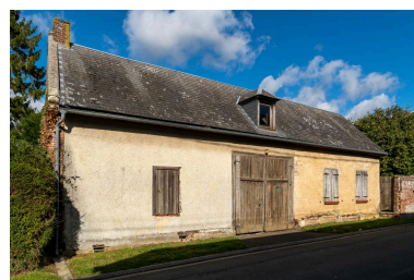
Grange et ancien atelier sur rue, n °3 rue Neuve, vue depuis le sud. Phot. Marc Kérignard IVR32_20216001023NUCA
