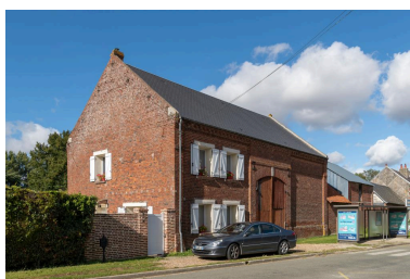
Logis et entrée charretière d'un ancien commerce, n°52 Grande Rue, vue depuis le sud-est. Phot. Marc Kérignard IVR32_20216001018NUCA
