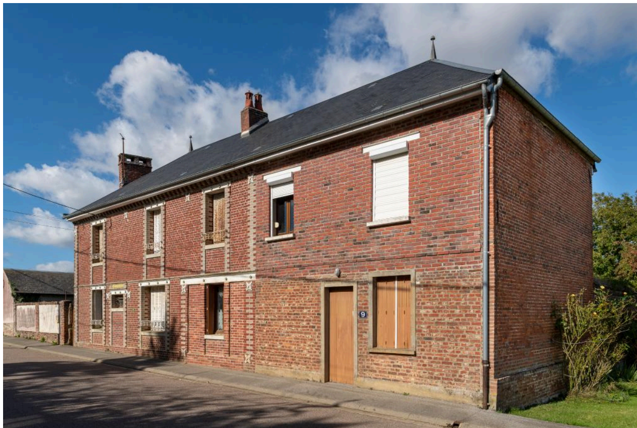
Logis sur rue, 1er quart 20e siècle avec agrandissement et reprises potérieures, n°9 rue de Breteuil, vue depuis le sud-est.
