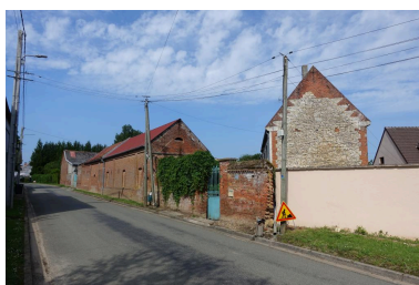
Ferme à cour, n°4 rue du Crocq, vue depuis l'est. Phot. Lucile Chamignon IVR32_20216005085NUCA
