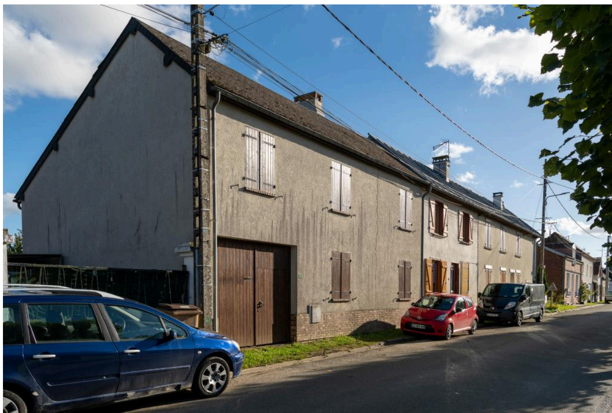
Anciens commerces (n°39 à 43), Grande Rue, vue depuis le nord.
