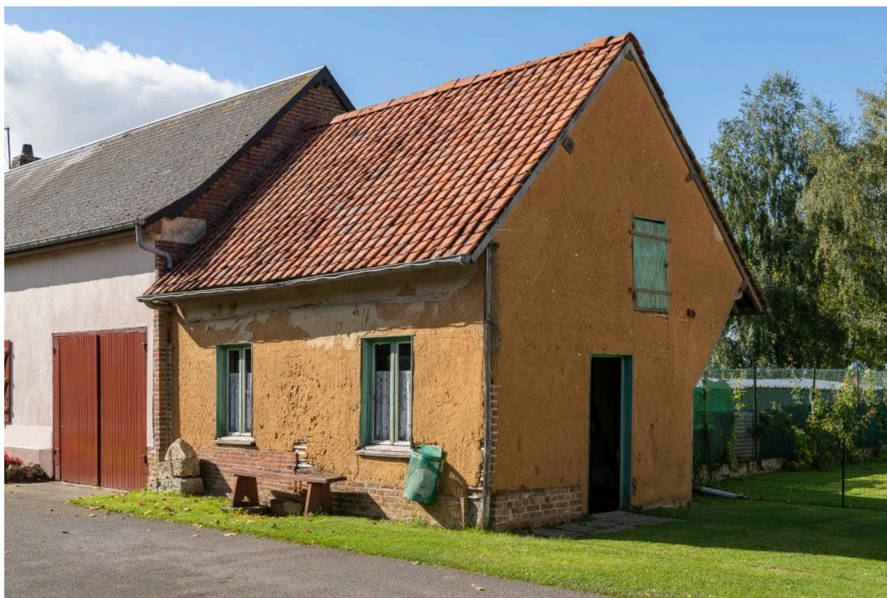
Ancien logis sur rue, n°40 Grande Rue, vue depuis l'est.
