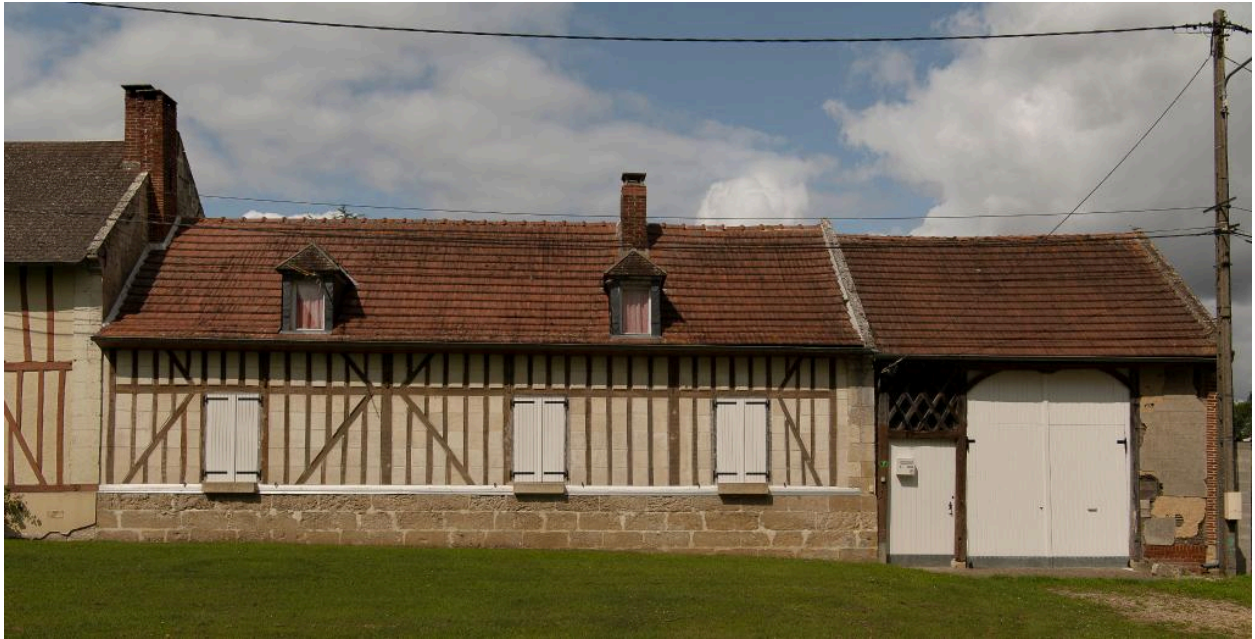
Logis avec porte piétonne à imposte ajourée, n°7 rue de l'Église, vue depuis l'est.
