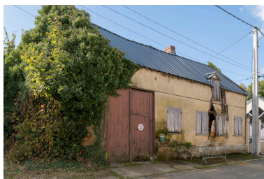
Ancien logis ou atelier sur rue (?), n°6 rue de la Mairie, vue depuis le nord-est. Phot. Marc Kérignard IVR32_20216000993NUCA
