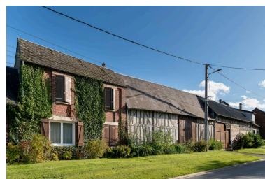
Vue générale de l'habitat (n°21 à 25 Grande Rue), vue depuis le nord-ouest. Phot. Marc Kérignard IVR32_20216001038NUCA
