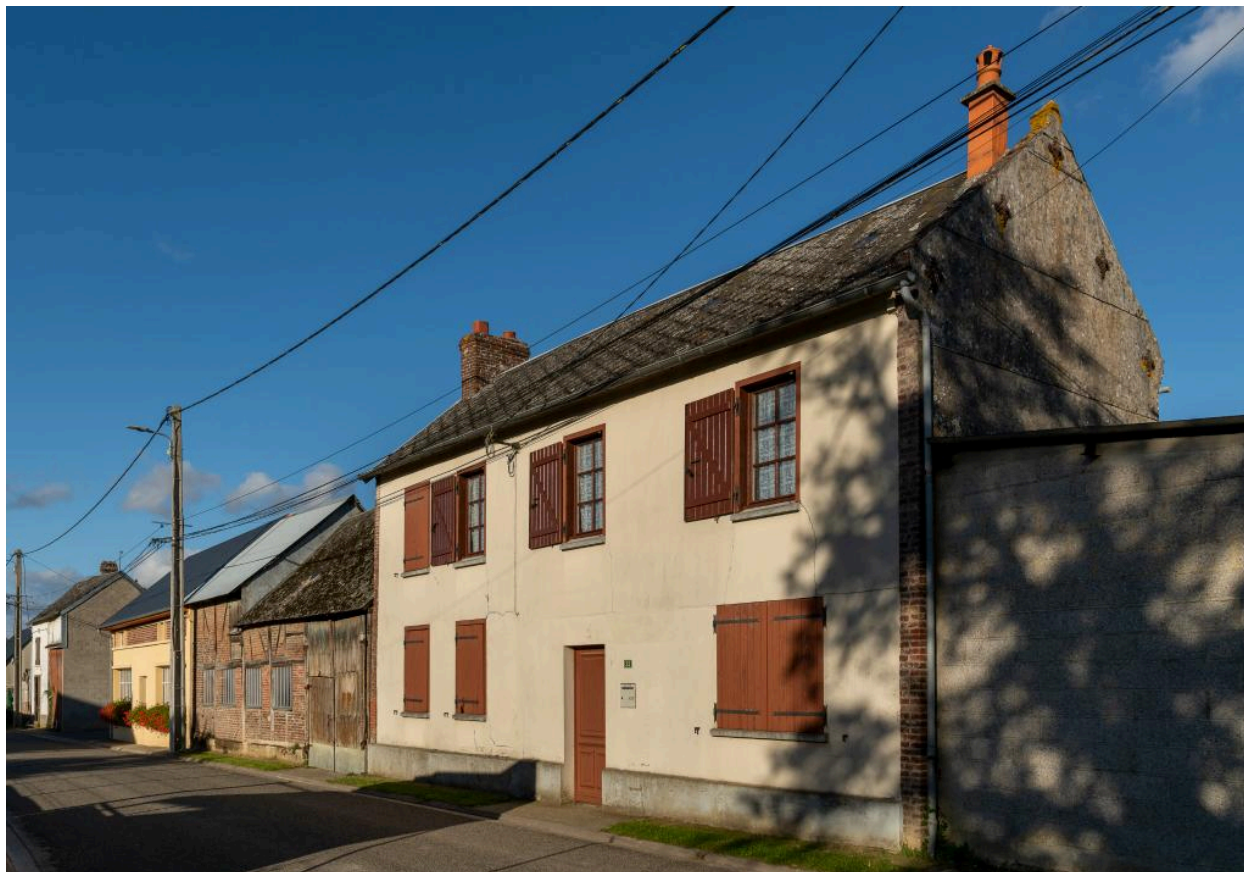
Ancien commerce (?), n°23 rue du Sac, vue depuis l'ouest.
