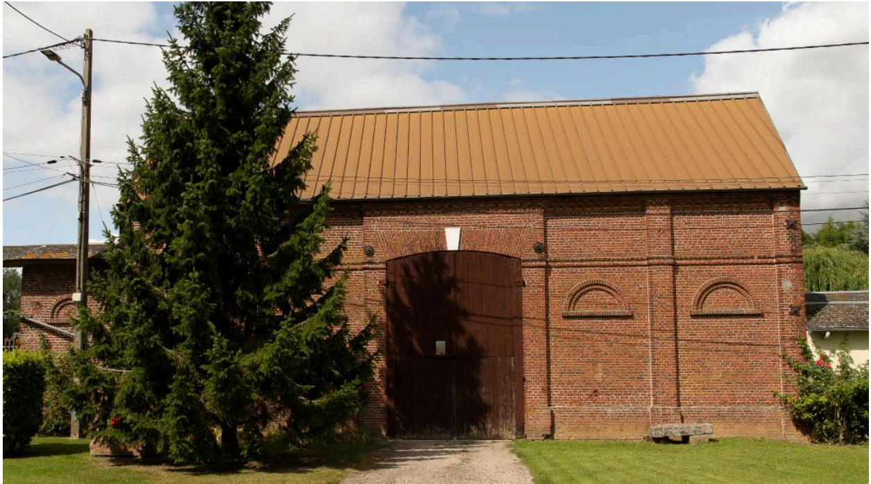
Grange, n°3 rue de l'Église, vue depuis l'est.
