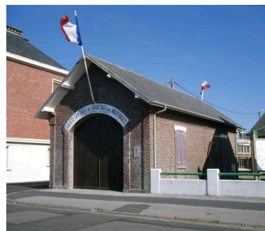
Vue d'ensemble depuis le boulevard du Général-Sizaire. Phot. Marie-Laure Monnehay-Vulliet IVR22_20048000331XA
