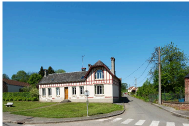
Vue d'ensemble de situation. Phot. Thierry Lefébure IVR22_20138000184NUC2A
