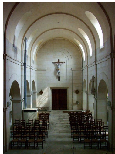
Vue intérieure de l'édifice. Phot. Inès Guérin IVR22_20030202126NUCA
