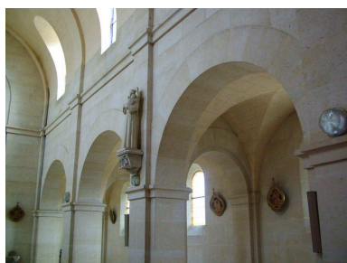
Vue des arcades de la nef. Phot. Inès Guérin IVR22_20030202127NUCA
