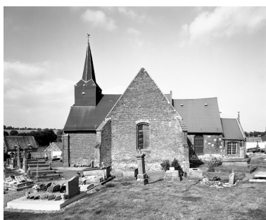
L'église vue du sud.
