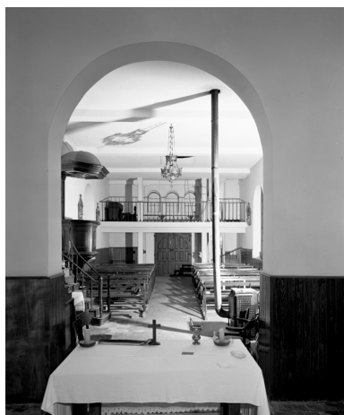
Vue intérieure depuis le chœur vers l'entrée.
