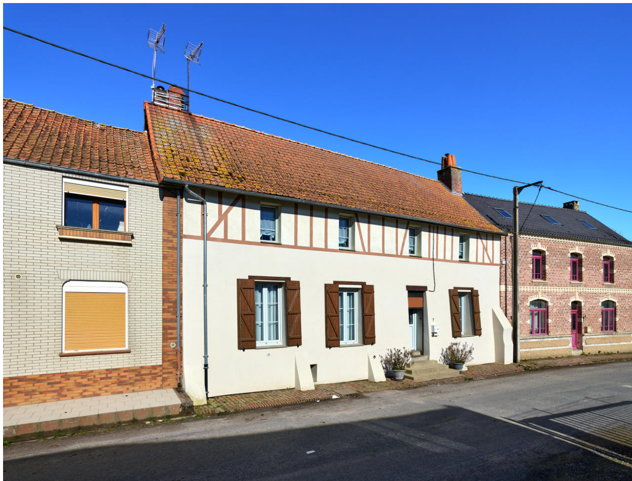
Vue générale de la façade.
