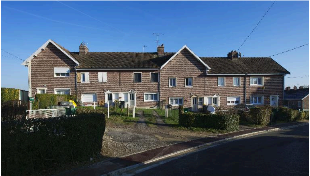
Vue de la façade antérieure d'un des immeubles à logements.
