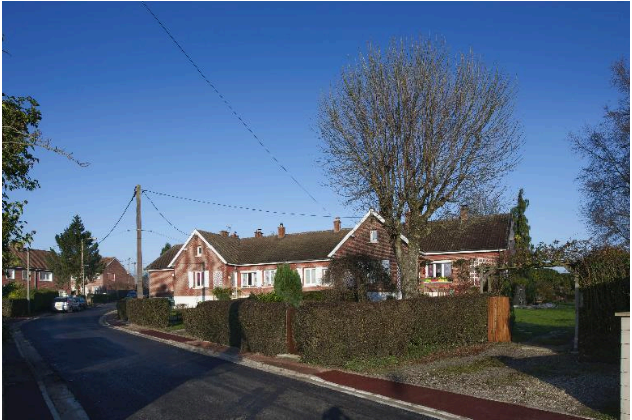
Vue des logements à deux unités d'habitation.
