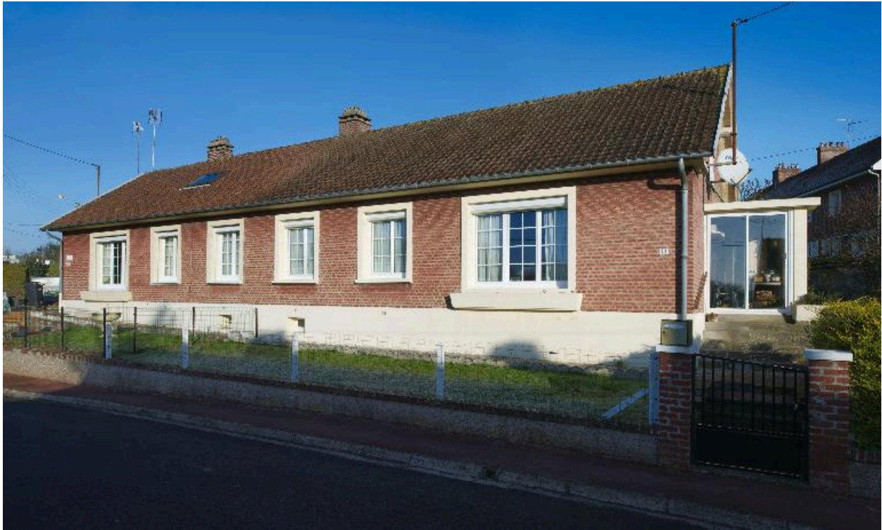
Maison à deux unités d'habitation, rue Bellevue.
