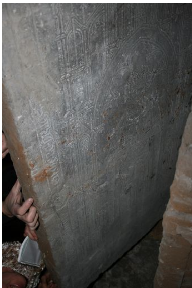
Vue générale. Phot. Olivier Liardet IVR31_20085906001NUCA
