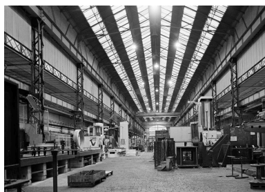
Atelier de fabrication principal : vue intérieure. Phot. Benoît Dufournier IVR22_19936002463Z
