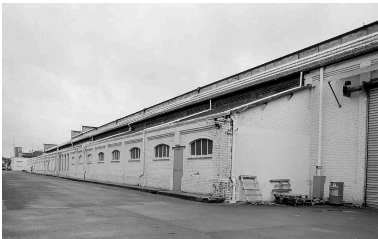
Atelier de fabrication principal : flanc sud.
