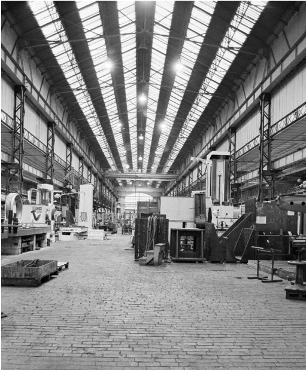
Atelier de fabrication principal : vue intérieure.
