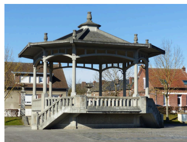
Le kiosque. Phot. Isabelle Barbedor IVR32_20220205013NUCA
