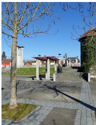
L'escalier de l'accès secondaire depuis l'avenue Jean-Jaurès. Phot. Isabelle Barbedor IVR32_20220205012NUCA
