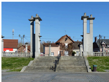
L'escalier de l'accès principal depuis l'avenue Jean-Jaurès. Phot. Isabelle Barbedor IVR32_20220205015NUCA
