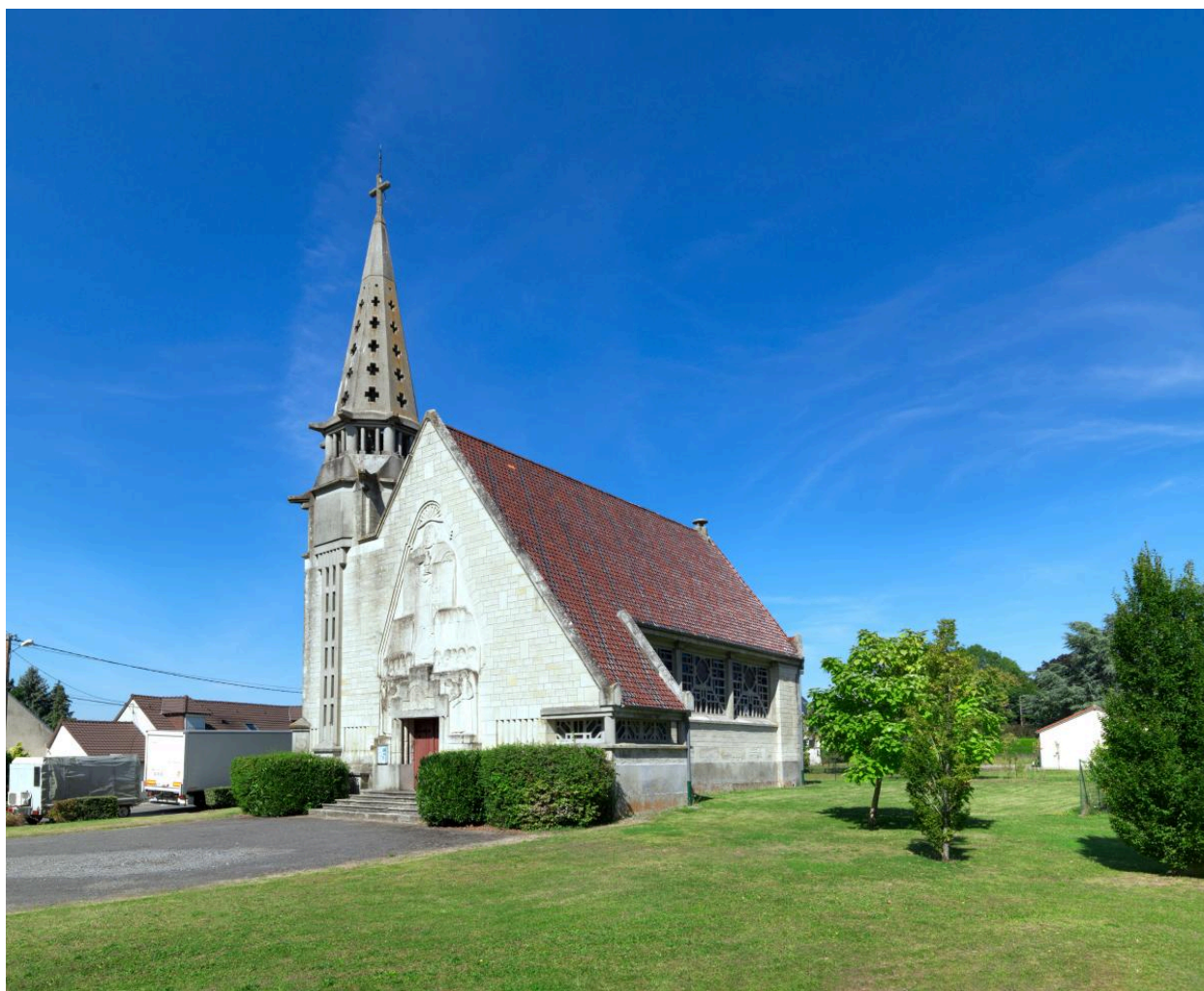
Vue générale, depuis le sud-est.
