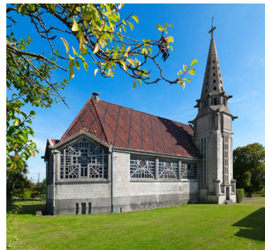
Vue générale, depuis le nord-ouest. Phot. Thierry Lefébure IVR32_20210200198NUCA
