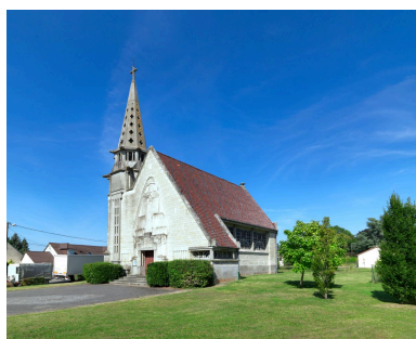
Vue générale, depuis le sud-est. Phot. Thierry Lefébure IVR32_20210200195NUCA
