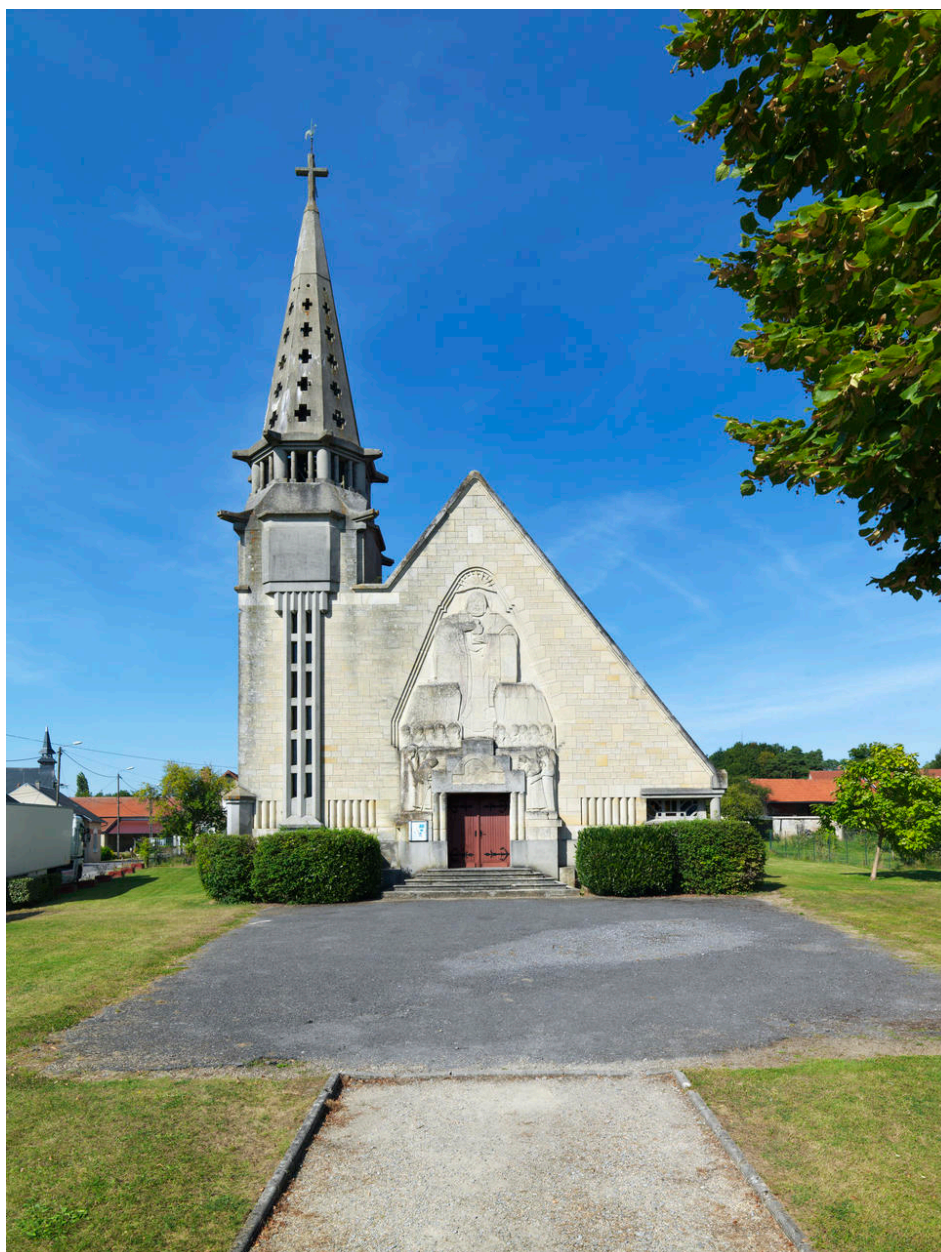
Vue générale de la façade.
