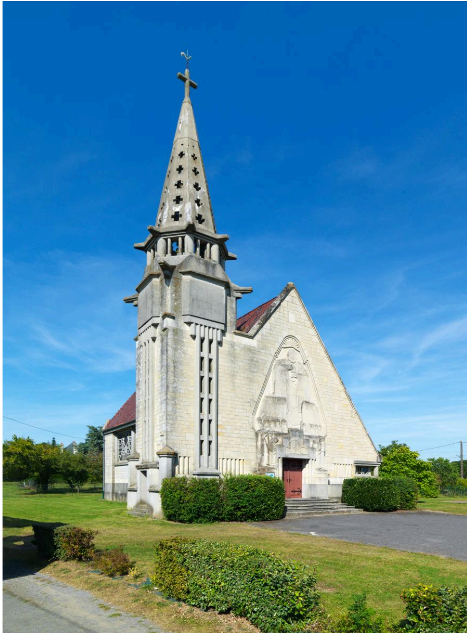
Vue générale depuis le sud-ouest.
