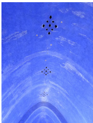
Détail de la voûte. Phot. Isabelle Barbedor IVR32_20160205130NUCA
