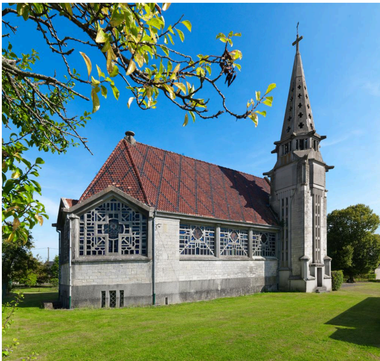
Vue générale, depuis le nord-ouest.
