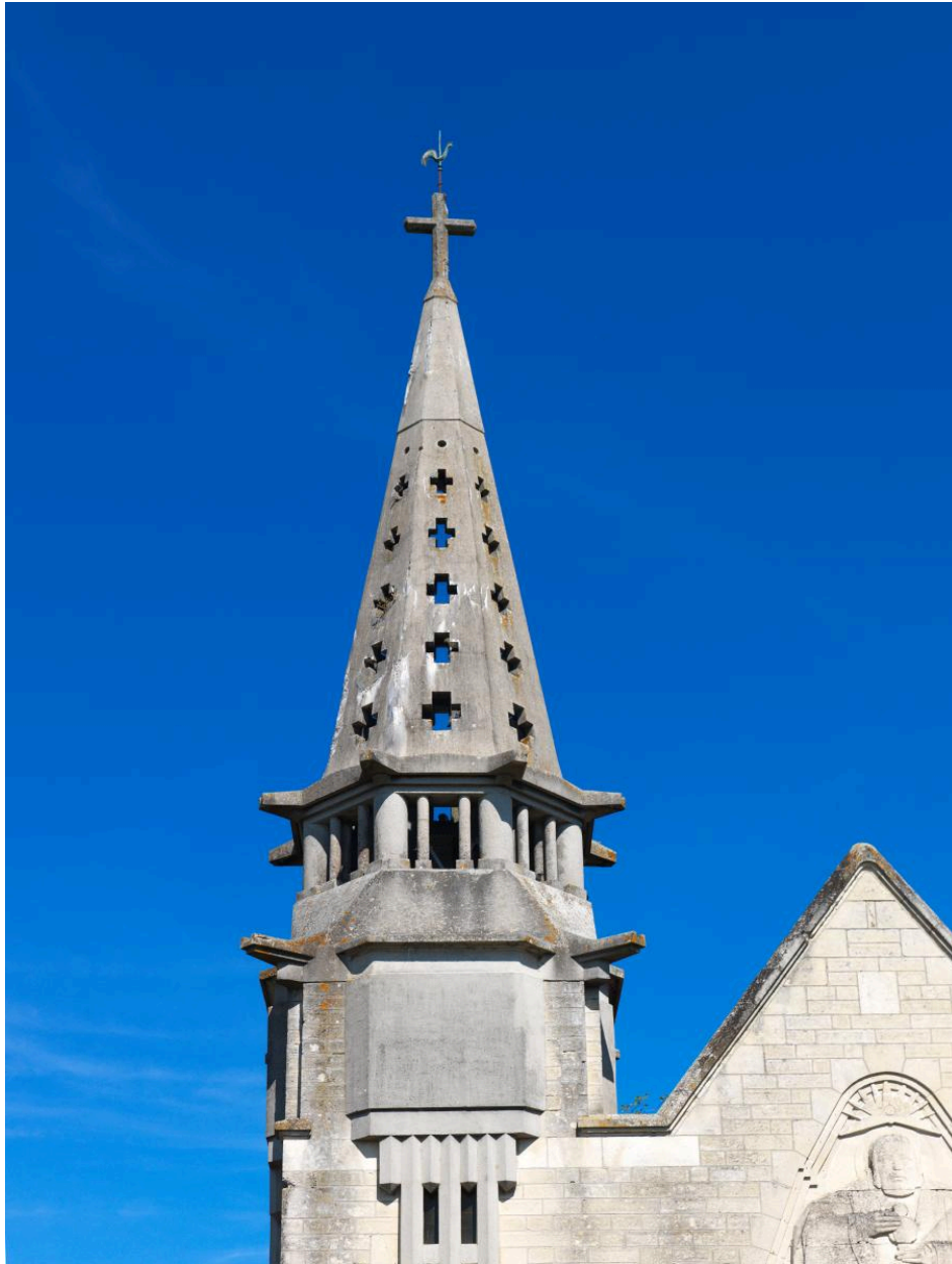
Vue de la partie supérieure du clocher.
