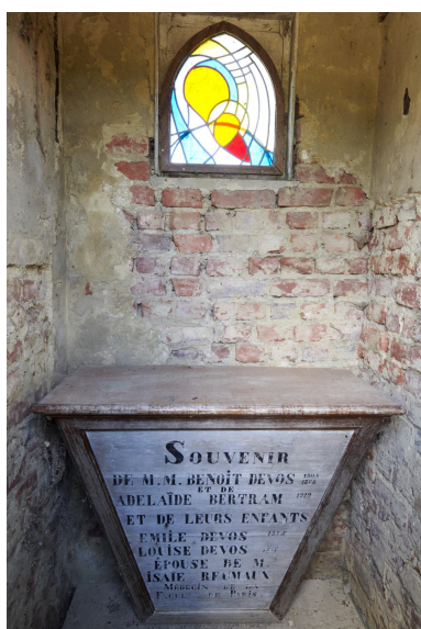
Intérieur de la chapelle. Autel et vitrail. Phot. Delphine Volto-Jourdan IVR32_20245902476NUCA
