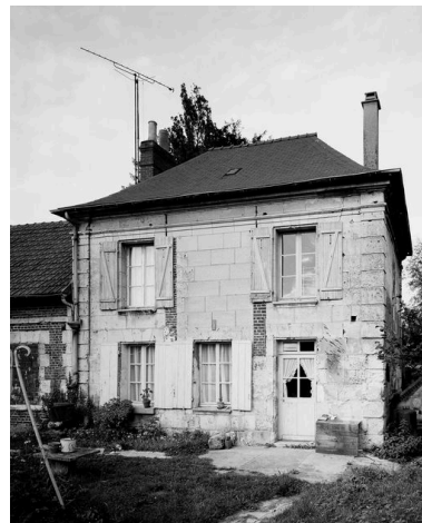
Elévation postérieure. Phot. Fabrice Charrondière IVR22_19856001406V
