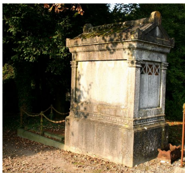
Vue générale postérieure. Phot. Caroline Vincent IVR22_20088000711NUCA
