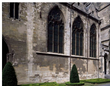
Traces des arcs du cloître sur le mur des chapelles sud du chœur. Phot. Thierry Lefébure IVR22_20090200160VA
