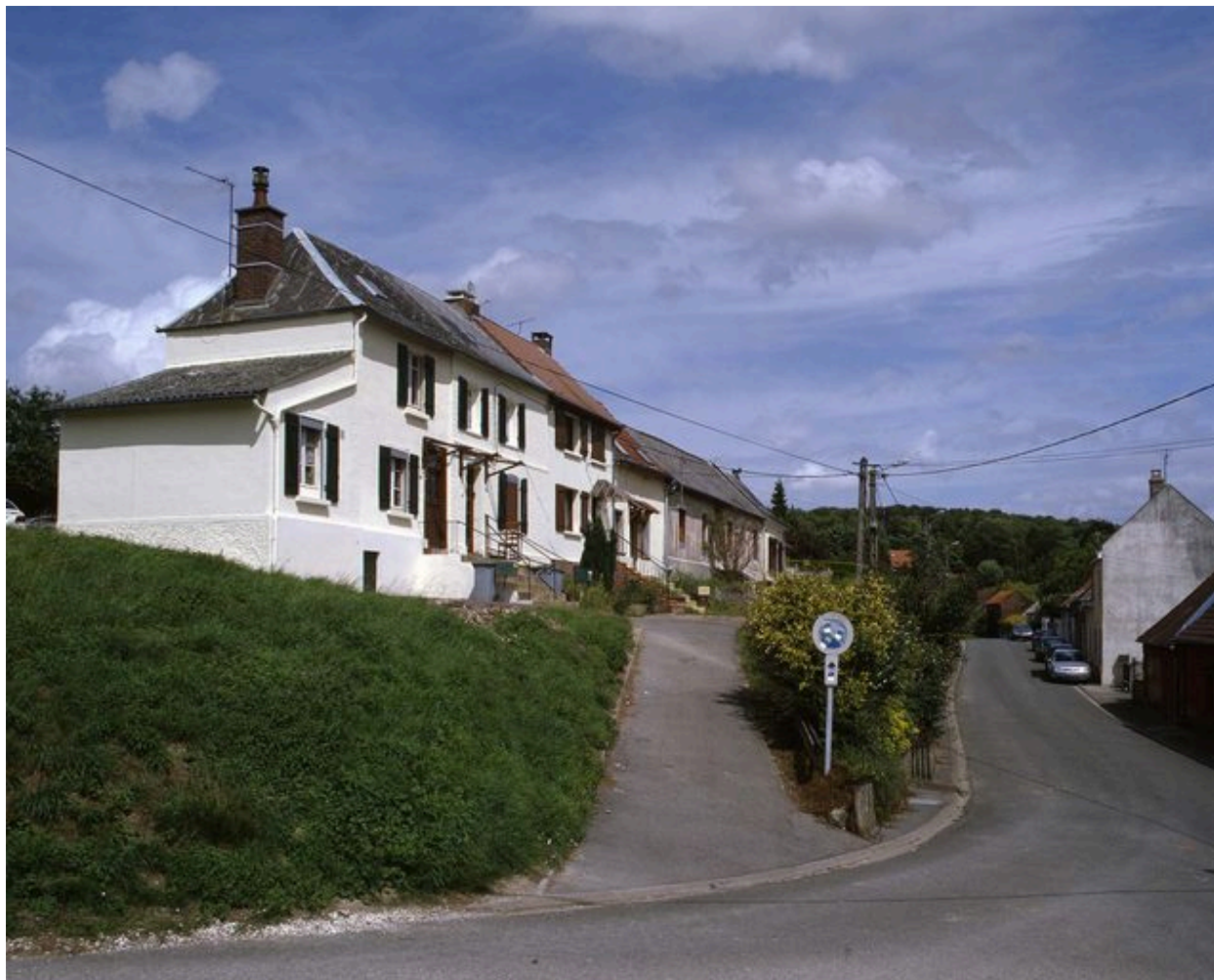
Les deux niveaux de la rue d'En-Haut, avec en partie supérieure l'alignement des maisons 192 à 237.
