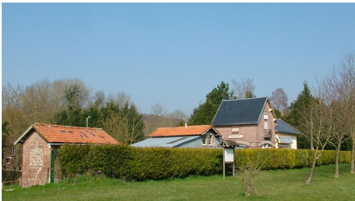
Ancienne gare, 21 rue du Pont-l'Évêque, datée de 1911 et complétée en 1925 (toilettes et lampisterie, buanderie).
