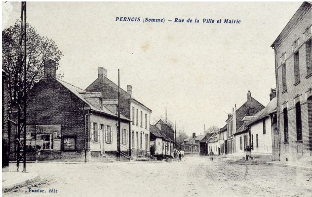
Rue de la Ville avec la mairie-école à gauche, avant 1914 (coll. part.).
