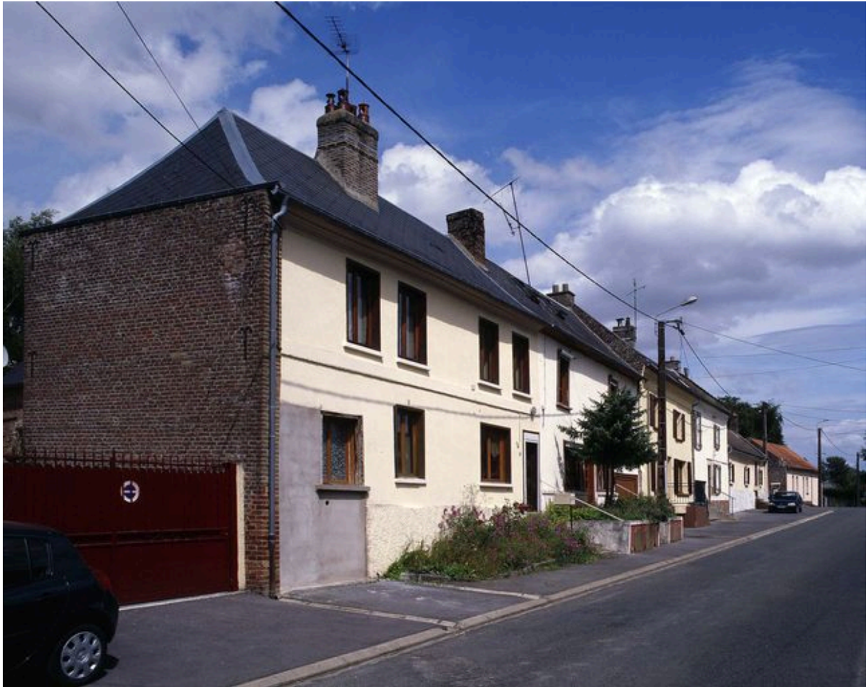
Alignement de maisons, 115-157 rue de la Ville, dont certaines étaient habitées par des tisserands au milieu du 19 e siècle.
