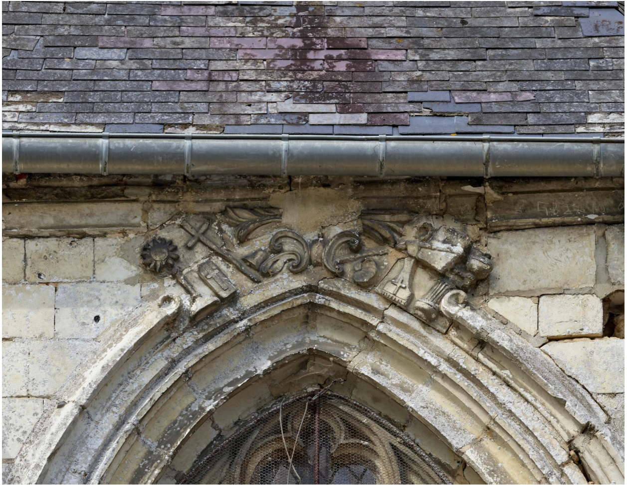
Détail des éléments sculptés sur l'archivolte d'une des baies du chœur, côté nord.
