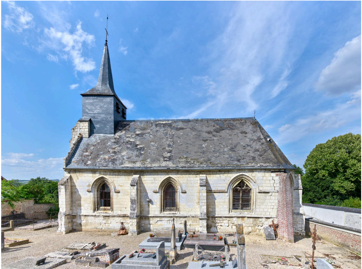
Vue d'ensemble sud.
