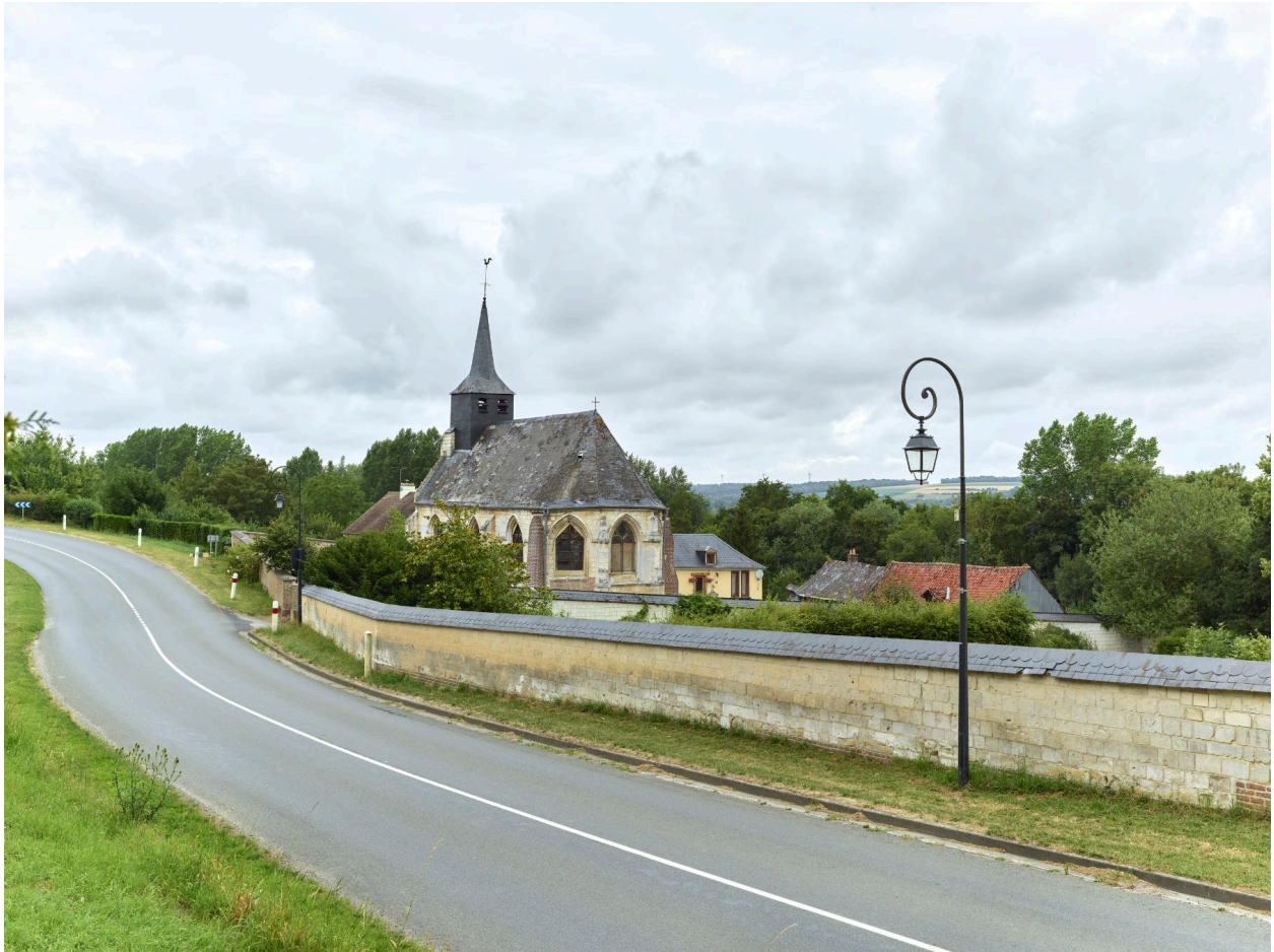
Vue générale de l'église et de son cimetière prise depuis le sud-est.
