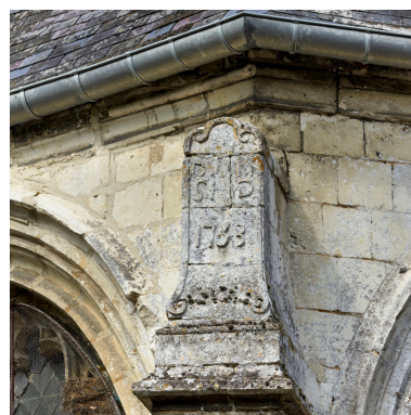
Détail du couronnement du contrefort du chevet portant en relief la date 1753. Phot. Thierry Lefébure IVR32_20238000304NUCA
