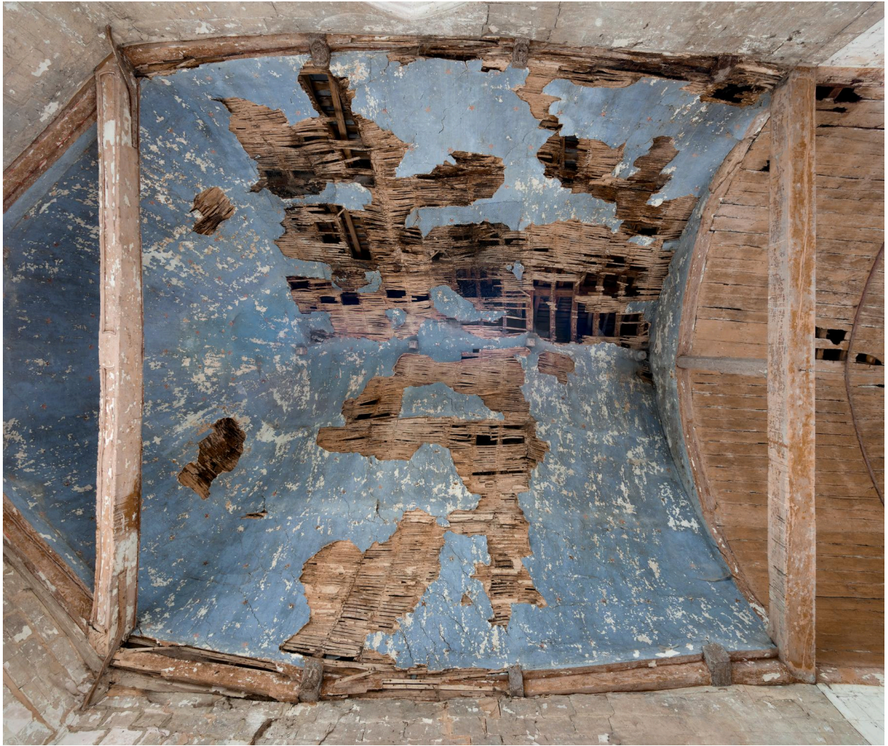
Voûte lambrissée du chœur, vue en contre-plongée.
