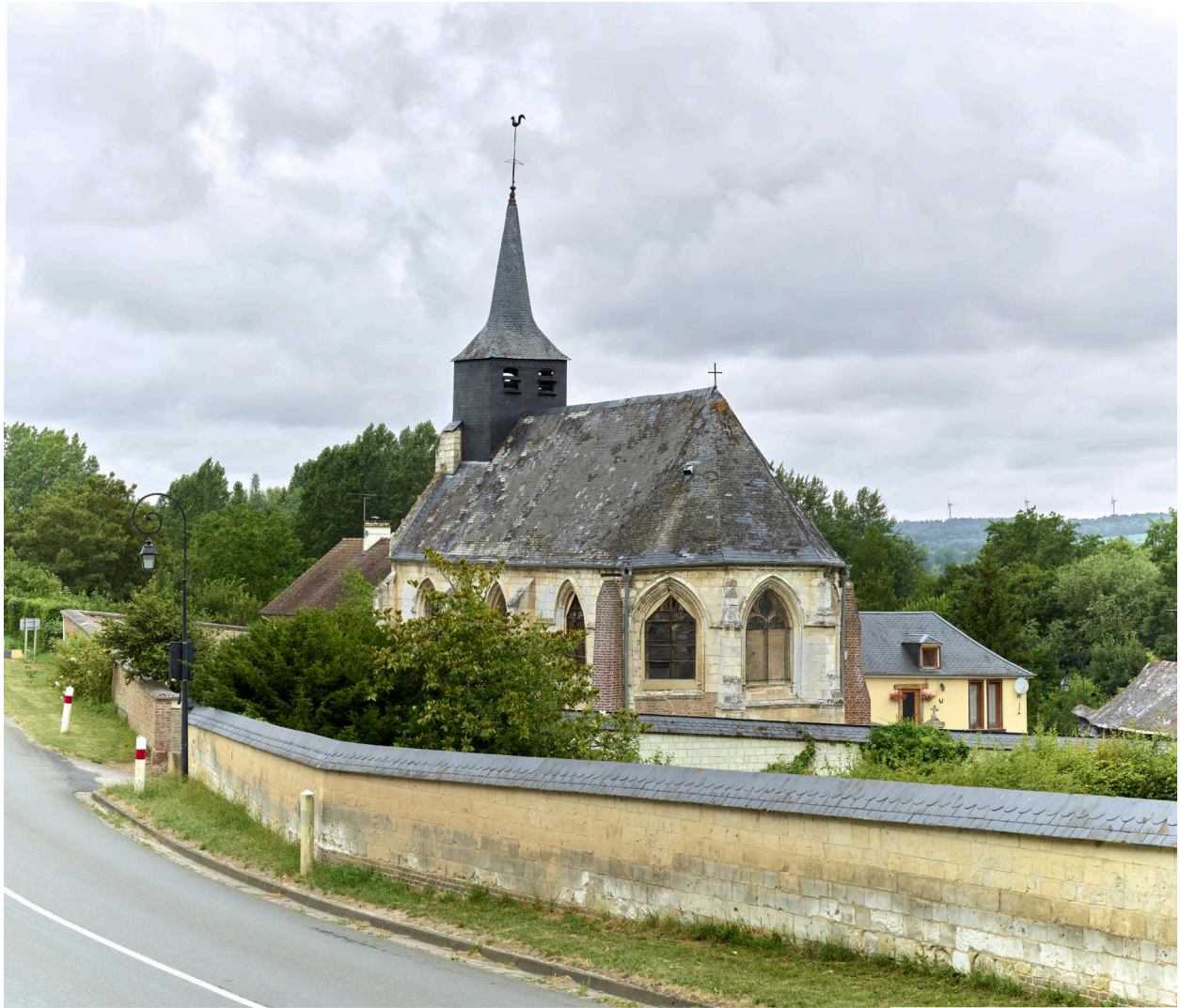
Vue générale sud-est.
