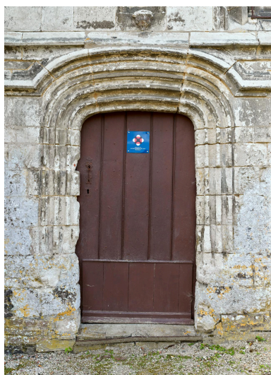
Portail latéral nord. Phot. Thierry Lefébure IVR32_20238000302NUCA
