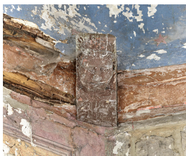
Blochet sculpté du chœur, à tête de personnage. Phot. Thierry Lefébure IVR32_20238000312NUCA
