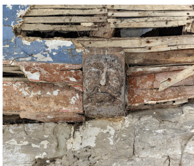
Blochet sculpté du chœur, à tête de personnage. Phot. Thierry Lefébure IVR32_20238000313NUCA
