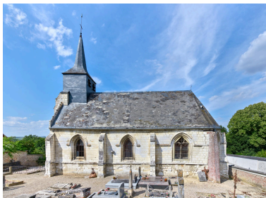
Vue d'ensemble sud. Phot. Thierry Lefébure IVR32_20238000296NUCA
