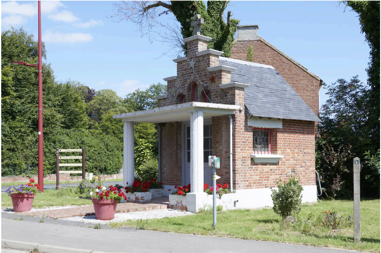
Façade et côté sud de la chapelle.
