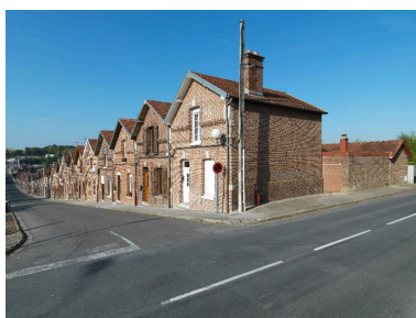
Vue d'ensemble depuis la rue de Bettencourt. Phot. Thierry Lefébure IVR22_20128000849NUC2A
