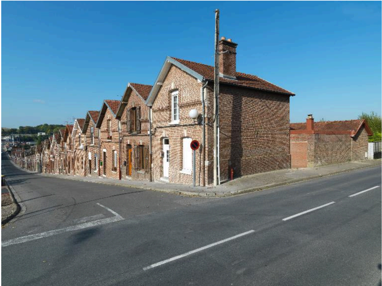
Vue d'ensemble depuis la rue de Bettencourt.
