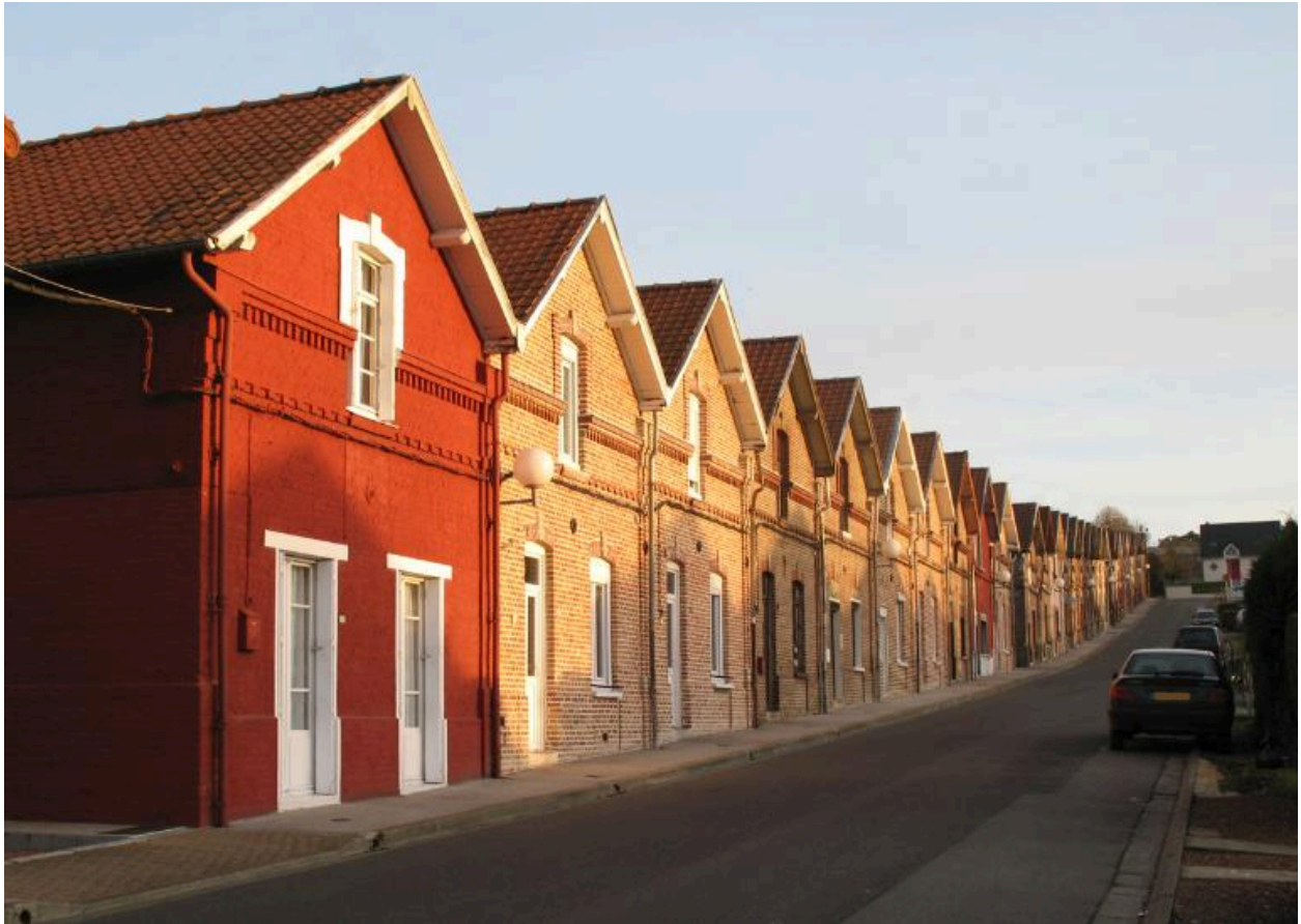
Vue d'ensemble depuis la rue Georges Outrebon.
