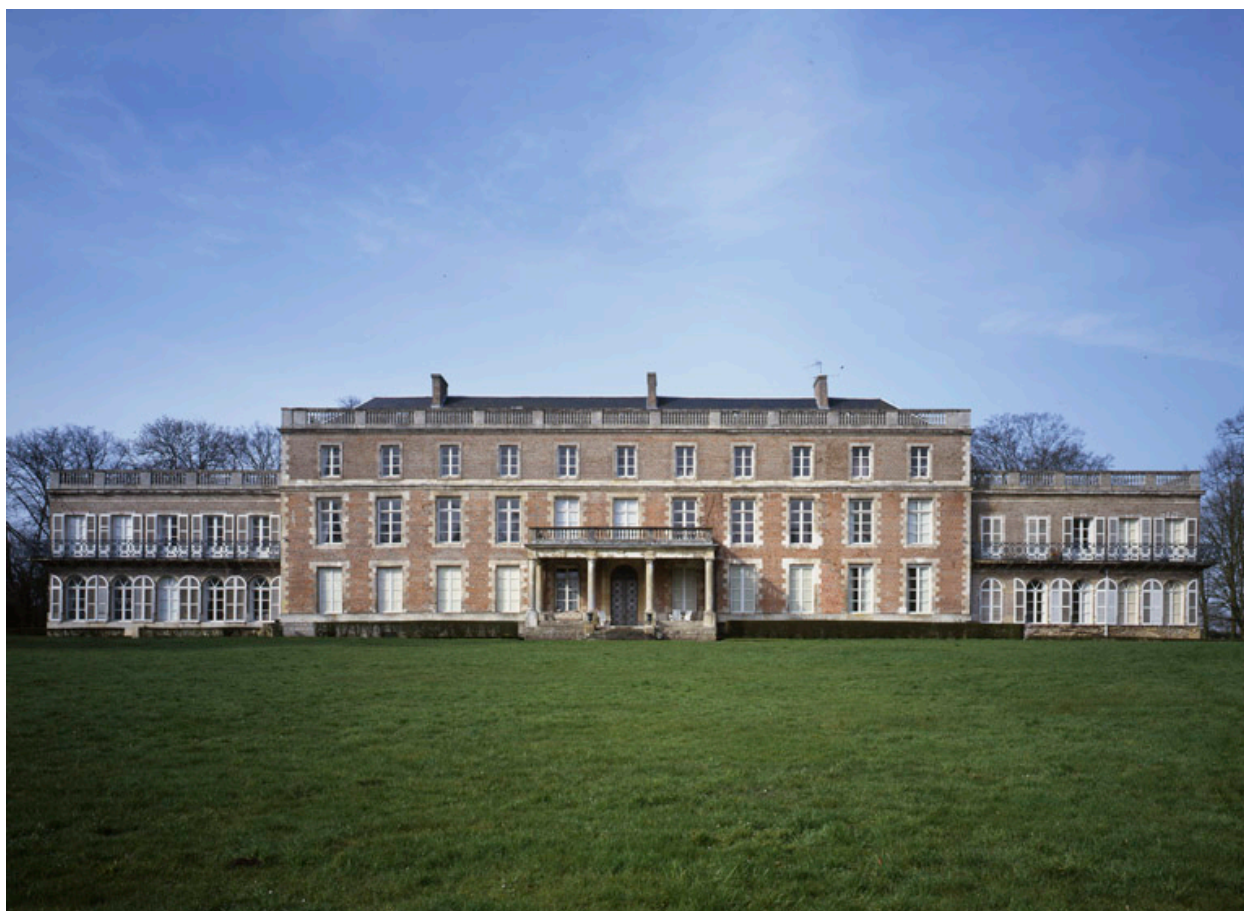
Le corps de logis : élévation orientale.
