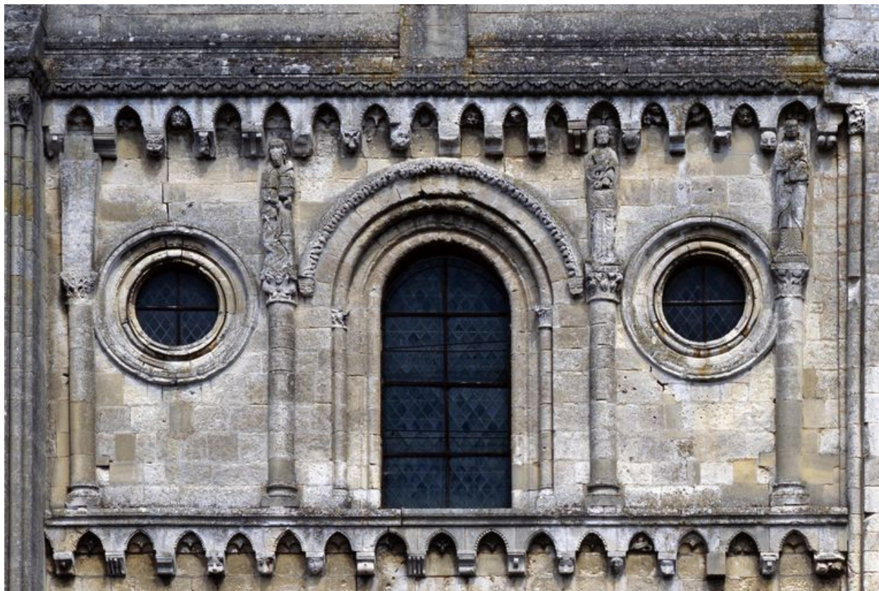
Deuxième niveau de la façade occidentale
