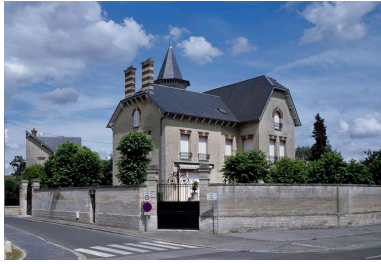
Vue générale de la maison du directeur. Phot. Thierry Lefébure IVR22_20106000836XA
