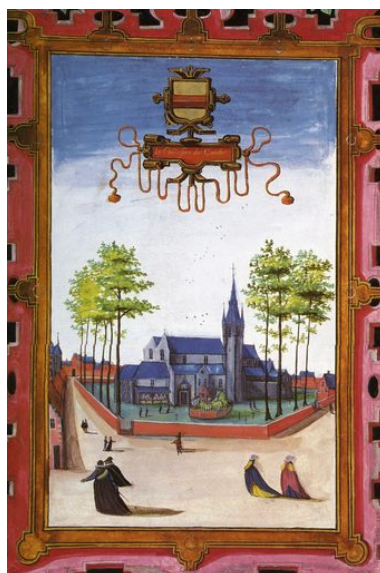
Vue générale de la collégiale dans son enclos, entre 1595 et 1610. In : Albums de Croÿ. Repro. Pierre Thibaut, Autr. Adrien de Montigny IVR31_20085900374NUCA
