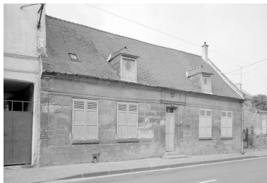
Elévation antérieure. Phot. Jean-Michel Perrin IVR22_19856000799X
