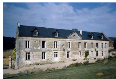
Logis. Elévation postérieure. Phot. Jean-Michel Perrin IVR22_19846001131XA
