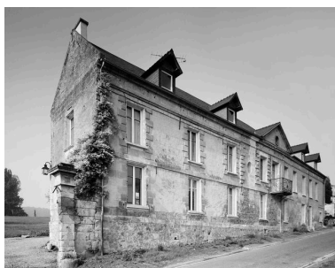
Logis. Elévation antérieure. Phot. Jean-Michel Perrin IVR22_19846001224V
