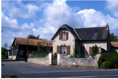
Vue générale. Phot. Inès Guérin IVR22_20030202805NUCA
