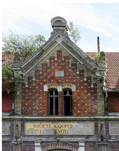
Détail de la façade portant la date de 1910.
