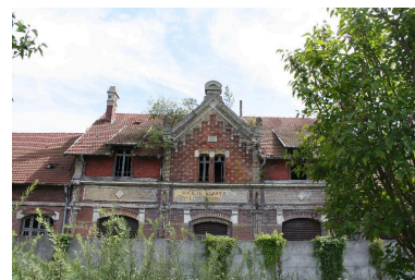
Vue partielle de la façade principale.
