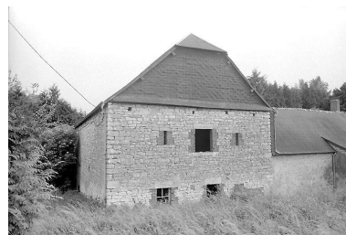
Elévation postérieure de la grange. Phot. Xavier-Philippe Guiochon IVR22_19980201498Z
