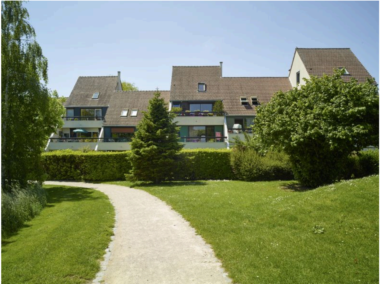
Ilot 4. Arrière des habitations. L'arrière des habitations donne sur le chemin piétonnier bordant le lac du Château. Les haies végétales marquent désormais la limite privé/public.
