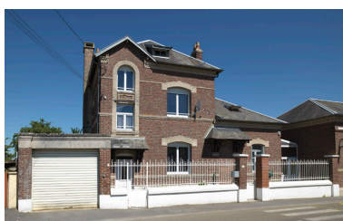
Vue du logement d'instituteur. Phot. Marie-Laure Monnehay-Vulliet IVR22_20158000654NUC2A
