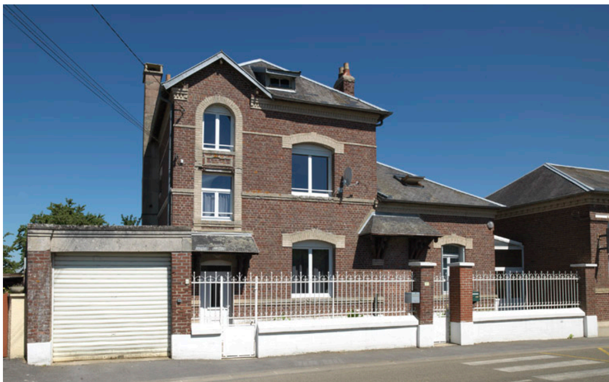
Vue du logement d'instituteur.
