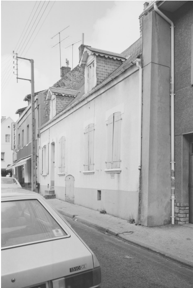
Vue générale de la maison depuis la rue. IVR31_19836200255X
