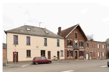
Anciens commerces de la place, vue prise depuis l'ouest. Phot. Marc Kérignard IVR32_20246000055NUCA
