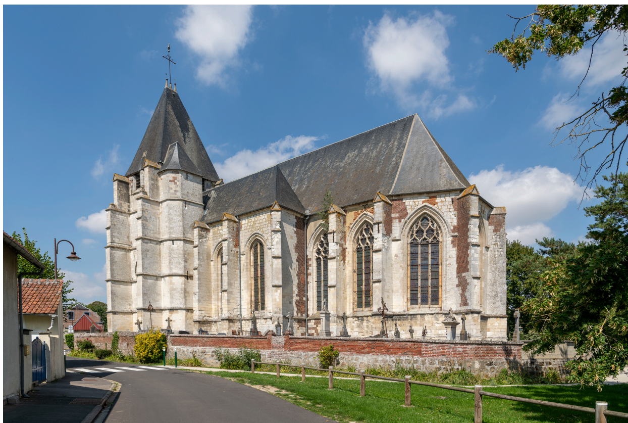
Église, vue prise depuis le sud-est.
